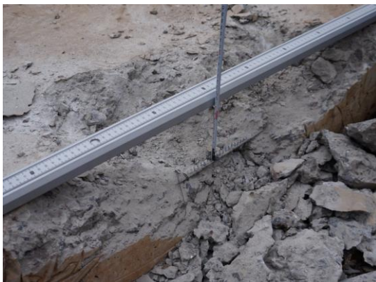
Рис. 3. Смещение верхней рабочей арматуры вглубь сечения железобетонной плиты
