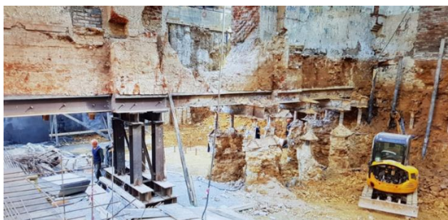
Рис. 5. «Пионерный» метод строительства «сверху вниз»
