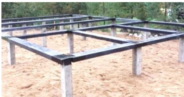
Рис. 1. Свайный фундамент с высоким ростверком
