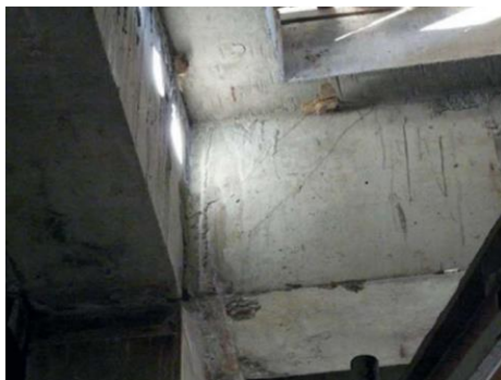
Рис. 3. Наклонные трещины в зоне сопряжения с колонной
