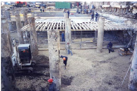
Рис. 2. Устройство инвентарной опалубки перекрытий, опирающейся на подготовленное грунтовое основание
