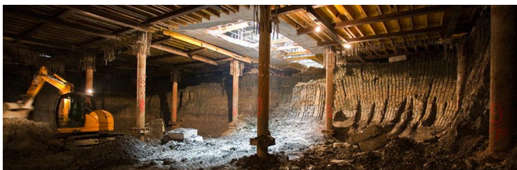
Рис. 1. Экскавация грунта из-под перекрытия через технологические отверстия плиты
