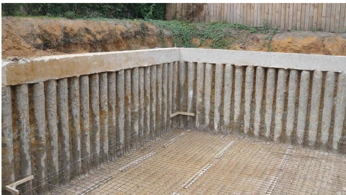
Рис. 2. Подпорная стенка, возводимая способом «стена в грунте» (в процессе строительства)
