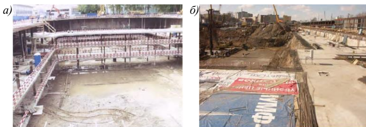
Рис. 3. Комбинированный способ строительства полу-полузакрытым методом: а – устройство перекрытий по первой схеме; б – по второй схеме
