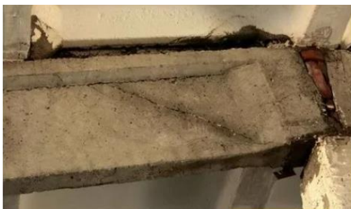
Рис. 4. Смещение сборно-монолитной железобетонной рамной конструкции
