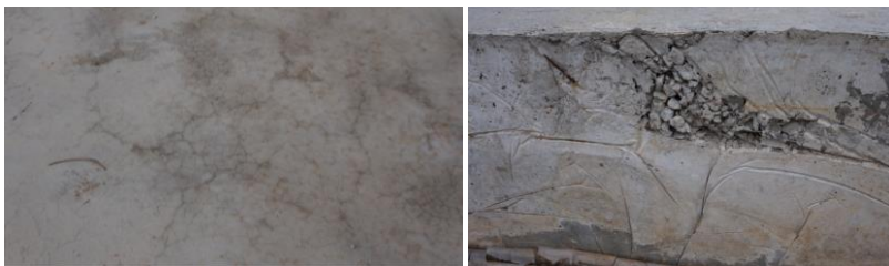
Рис. 4. Дефекты бетонирования железобетонной фундаментной плиты
