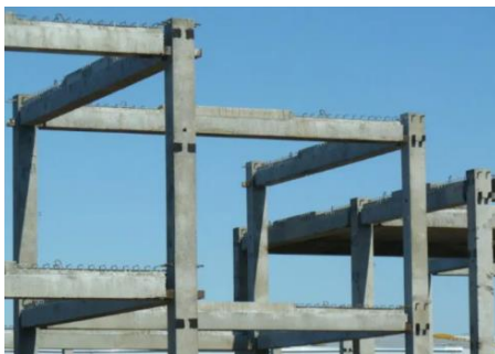
Рис. 2. Сборно-монолитная железобетонная рамная конструкция
