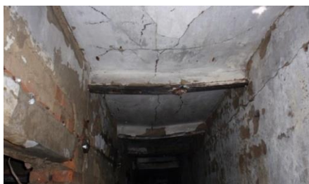
Рис. 4. Деформация перекрытий
