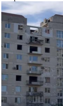
Рис. 5. Локальное разрушение здания
