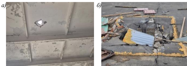
Рис. 4. Состояние плит покрытия (а) и кровли (б)
