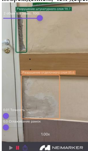
Рис. 3. Дефекты и повреждения внутренних конструкций
