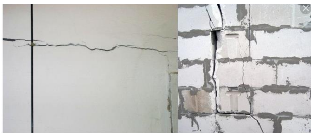
Рис. 2. Горизонтальная и вертикальная трещина
