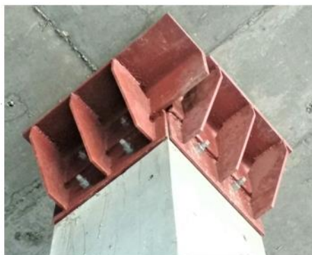
Рис. 5. Установка стальных капителей усиления зон продавливания
