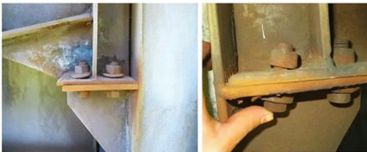
Рис. 2. Дефекты болтовых соединений
