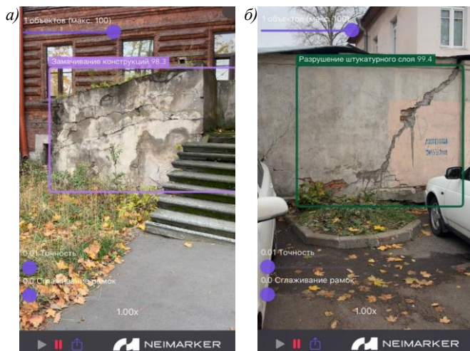
Рис. 2. Дефекты и повреждения оштукатуренных каменных конструкций: а – ограждение приемка; б – наружная стена пристройки
