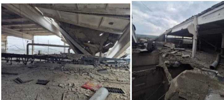
Рис. 2. Обрушение пролетов надсиловосного этажа
