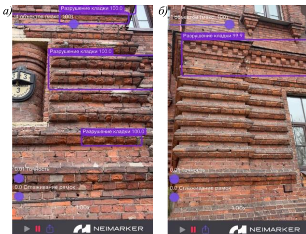
Рис. 1. Дефекты и повреждения фасадов кирпичного здания: а – 1-й результат; б – 2-й результат
