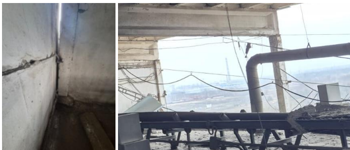
Рис. 5. Состояние наружных стеновых панелей
