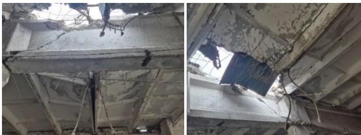
Рис. 3. Состояние балок и плит перекрытия
