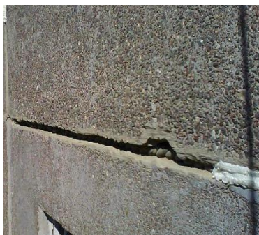
Рис. 3. Заделка межблочных швов
