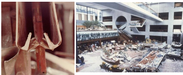
Рис. 2. Деформированная балка моста и последствия аварии
