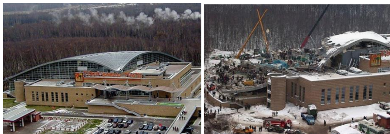
Рис. 3. Покрытие аквапарка до и после обрушения
