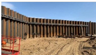
Рис. 2. Шпунтовое ограждение в процессе монтажа
