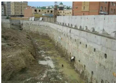
Рис. 3. Процесс устройства, стены в грунте
