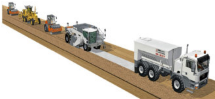
Рисунок 1 - Последовательность выполнения операций методом холодной регенерации
