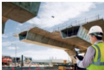
Рисунок 2 - Контроль строящегося моста с дрона
