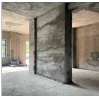
Рисунок 2 - Реальная железобетонная диафрагма жёсткости в каркасе здания (вертикальный элемент)
