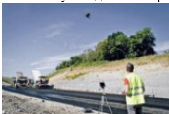
Рисунок 1 - Мониторинг дроном при строительстве автомобильных дорог
