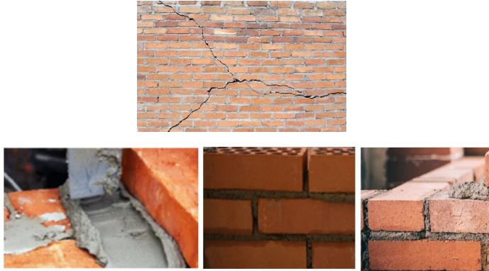
Рис. 6. Влияние деформативных свойств раствора на напряженно-деформированное состояние кирпича
